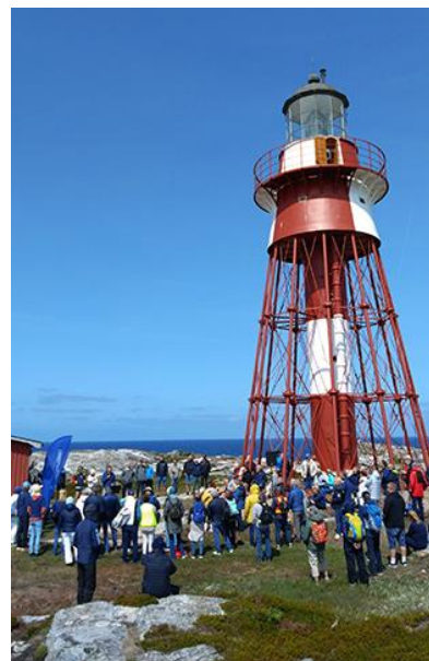
Måseskärs fyr på Västkusten – ett statligt byggnadsvårdsminne som totalrenoverats av Sjöfartsverket. Foto: Sjöfartsverket
